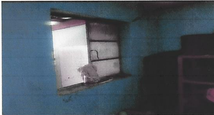
Foto 1: Sustitución de ventanas de metal por PVC mas vidrio
