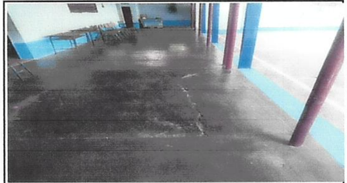
Foto 2: Reparacion de grieta y sustitucion de concreto por piso ceramico anti deslizante
